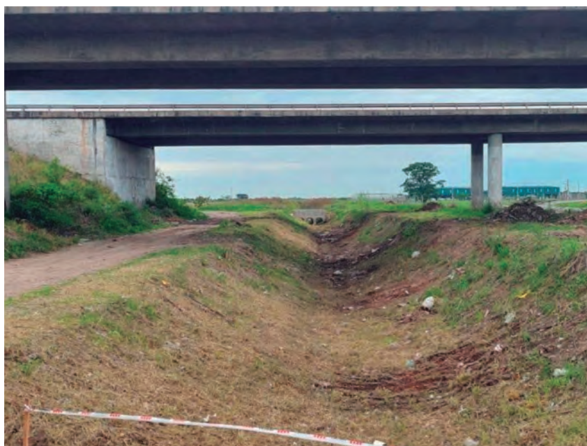
Canal Alejandro Heredia-Ampliación Federal. Tareas de rectificación de sección, limpieza , desmalezado y levante de residuos
