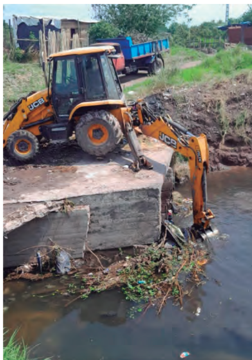
Canal Termoeléctrica. Tareas de limpieza general, rectificación de sección, desmalezado y levante de Residuos
